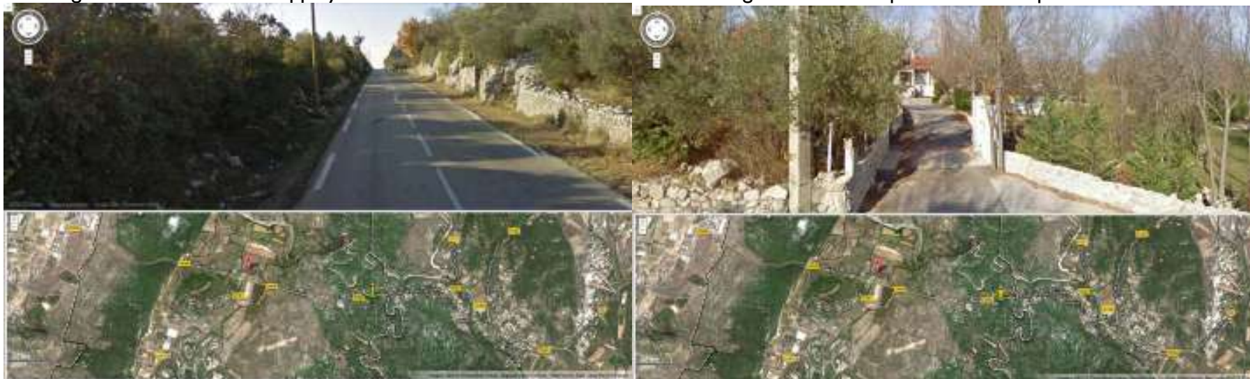
Vue Singla direction de Saint-Hippolyte / effet couloir - murs de soutènement / végétation climacique / dénivelé important / recul bâti
