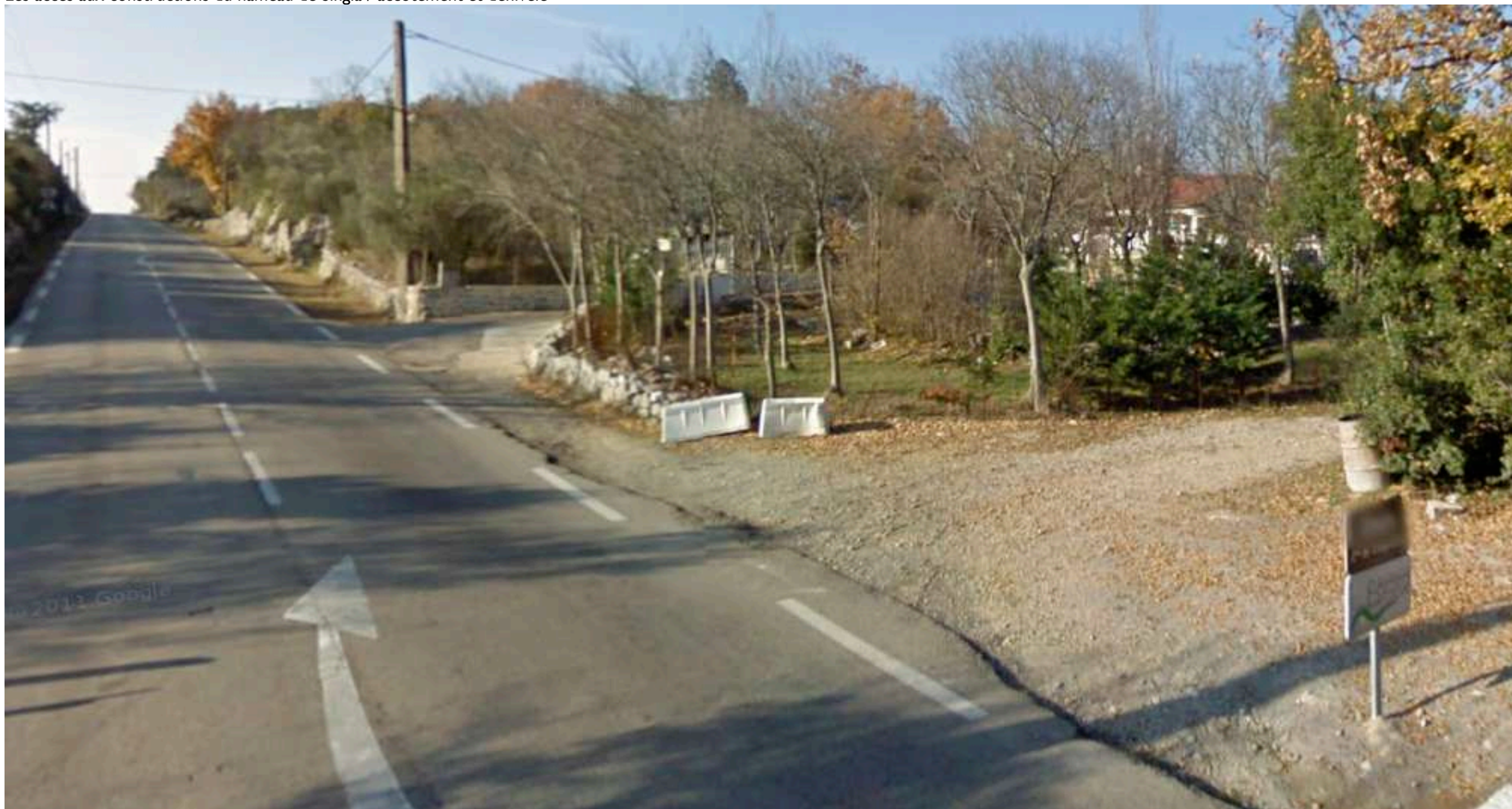
Les accès aux constructions du hameau de Singla / accotement et dénivelé
