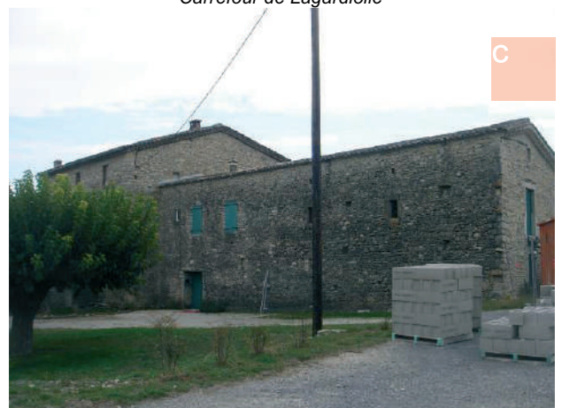
Ensemble bâti de la Mairie
